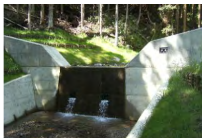
治山ダム工の設置
