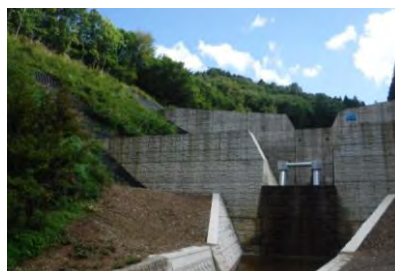
砂防堰堤の設置
