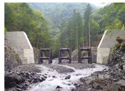
治山：溪間工（スリットダム）
