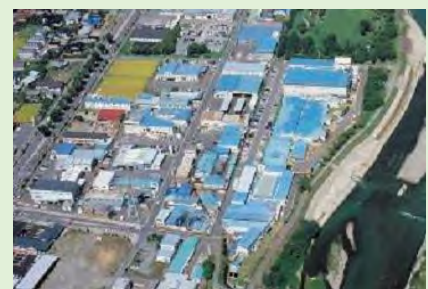
天竜川沿いの工場
