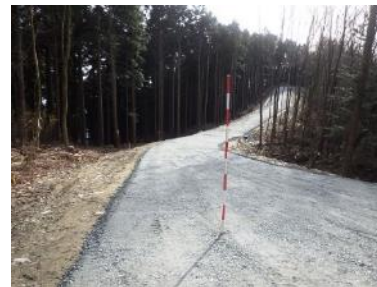
【森林整備:林道(整備)】
