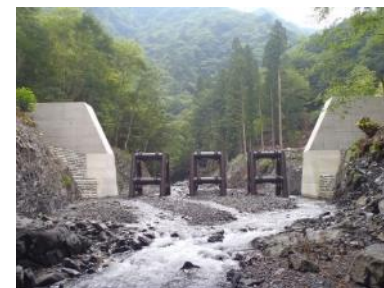
【治山:溪間工(スリットダム)】
