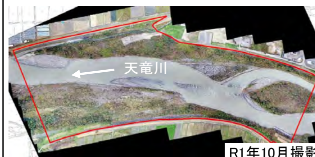
山吹地区 (H24整備)
