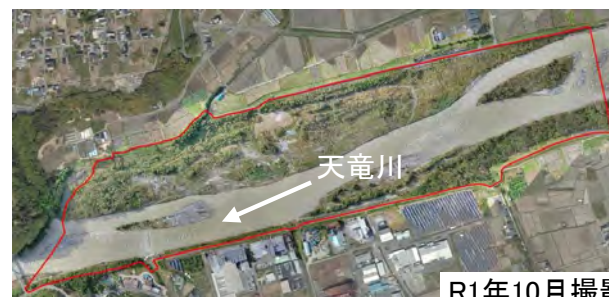
元大島地区 (H20-21整備)
