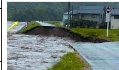
(H18.7洪水:箕輪町松島地区) ※天竜川右岸204.8km 堤防決壊箇所
