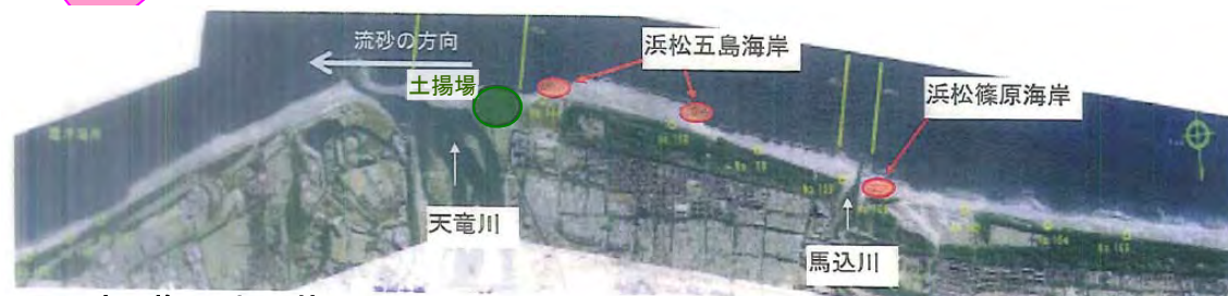
土砂の搬入先の状況
