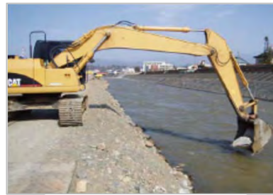
大石の設置状況
