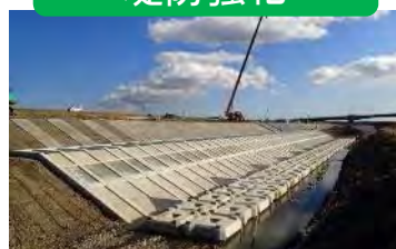
扇頂部対策 (左岸21.4k付近)
