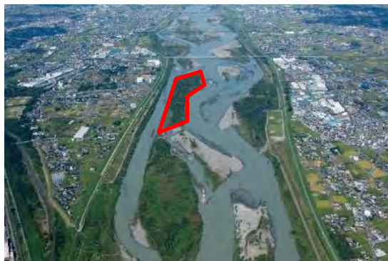
樹木抜開予定箇所（5 k 付近の例）
