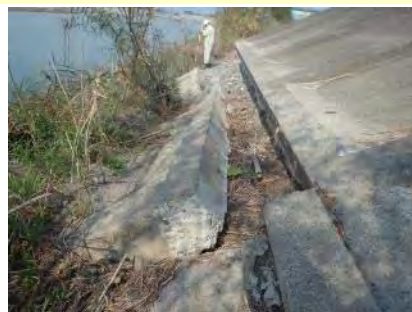
河川管理施設の点検
