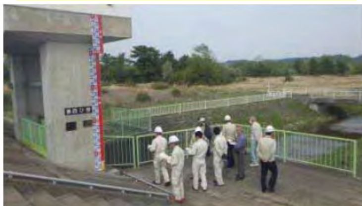
樋門の定期点検
