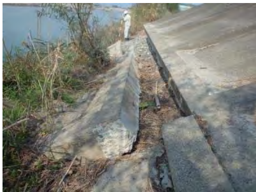
河川管理施設の点検
