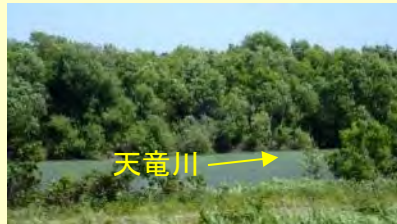
現在の河道の状況 (H30.5_6k付近)
