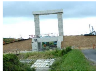
下前田川の水門・堤防整備
