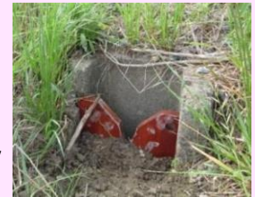
田んぼへ設置したスリット堰
