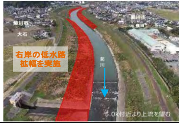
R4河道掘削(5.0k付近)
