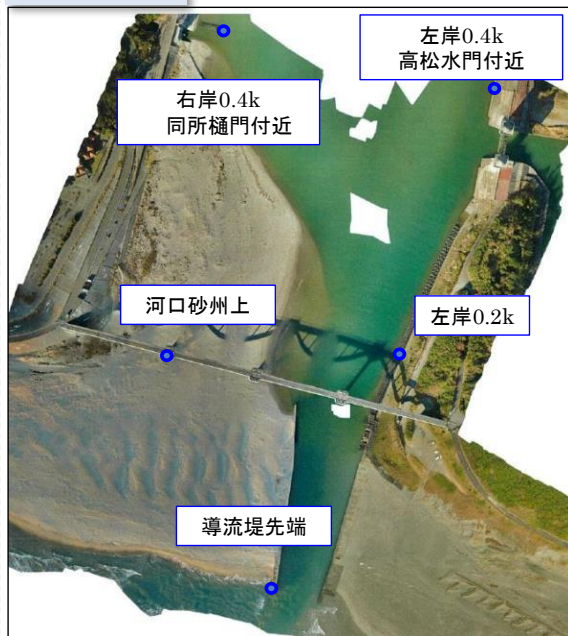
水位計設置位置
