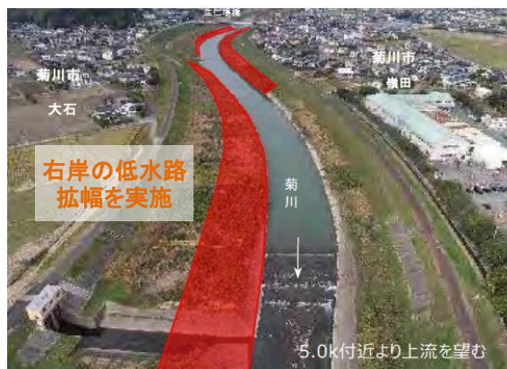
河道掘削予定箇所 菊川5.4k付近
