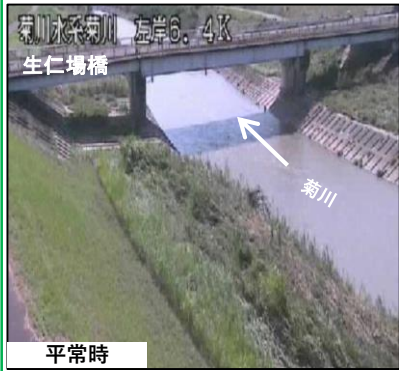
出水状況【嶺田水位観測所(6.4k)付近】
