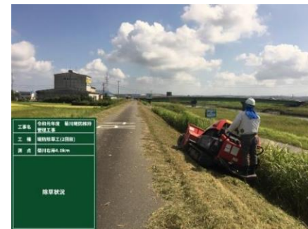
堤防除草作業の様子
