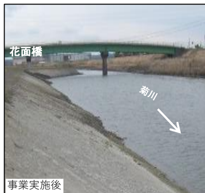
河床掘削による流下能力の向上【菊川4.0k施工状況】
