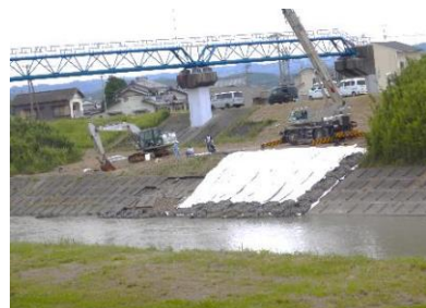
5.4k 護岸復旧工事の様子
