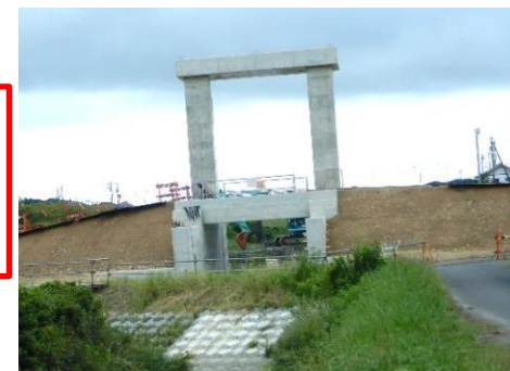
堤防整備箇所 菊川右岸14.3k付近
