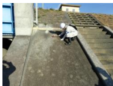
出水期前河川施設点検の様子
