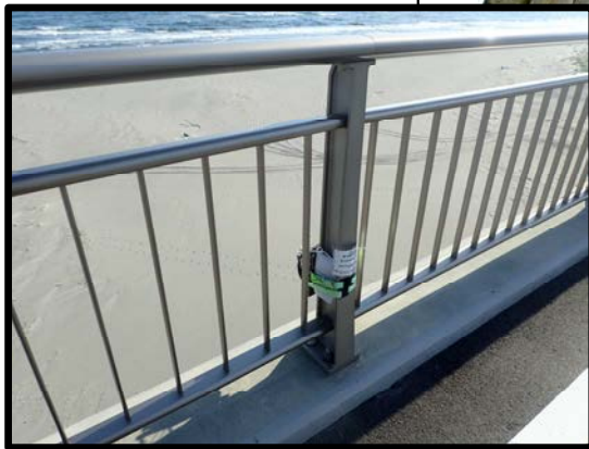
タイムラプスカメラの設置
