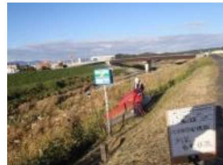
堤防除草作業の様子
