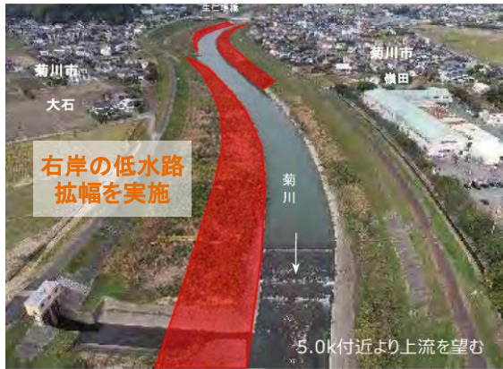
河道掘削予定箇所
