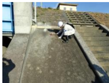
出水期前河川施設点検の様子
