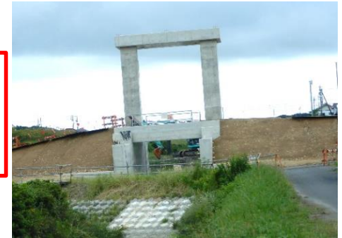
堤防整備箇所 菊川右岸14.3k付近
