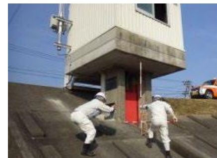
河川巡視の様子
