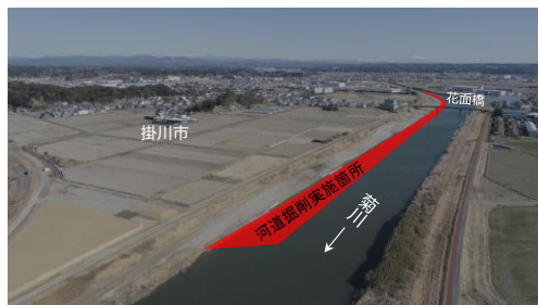
令和3年度河道掘削実施範囲 (菊川3.5k付近)
