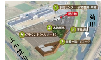
下内田地区河川防災ST
