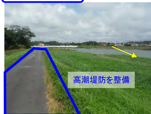
高潮堤整備箇所 菊川右岸1.1k付近
