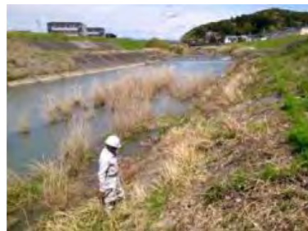
出水後巡視での護岸確認
