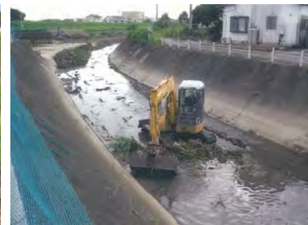
黒沢川 0.1k~0.3kの河道掘削
