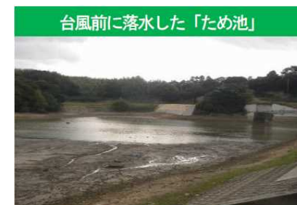
(H26.10 淡路市志筑 黒田池)
