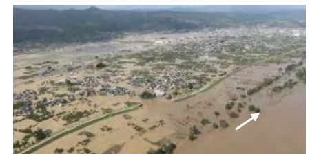
長野市穂保地先の堤防決壊、 浸水被害状況
