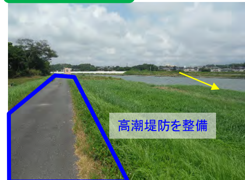
高潮堤整備箇所 菊川右岸1.1k付近
