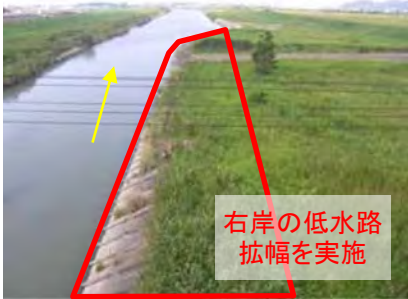
河道掘削予定箇所 菊川右岸4.2k付近
