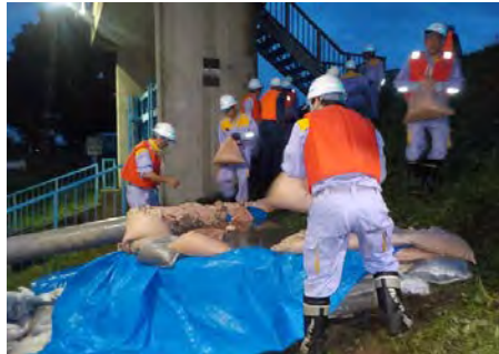
岐阜市水防団 漏水対策
