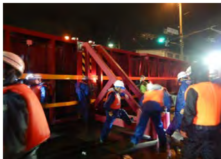
岐阜市水防団 陸閘操作
