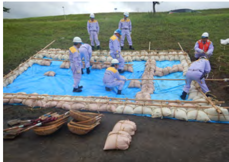
岐阜市水防団 堤防法崩れ対策
