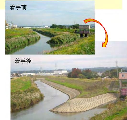
牛淵川 3.1k付近 除草・土砂撤去
