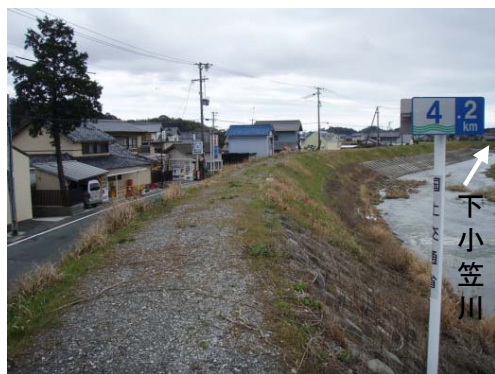
下小笠川 4.2k付近の河道および背後地の状況 (H22年2月撮影)
