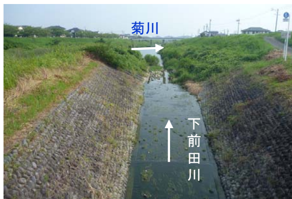
下前田川 菊川合流点(14.3k付近)の状況 (H28年11月撮影)
