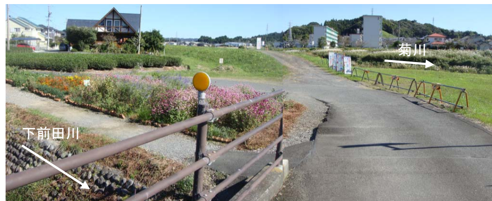
菊川 14.2k付近右岸 下前田川合流点（H28年11月撮影）
