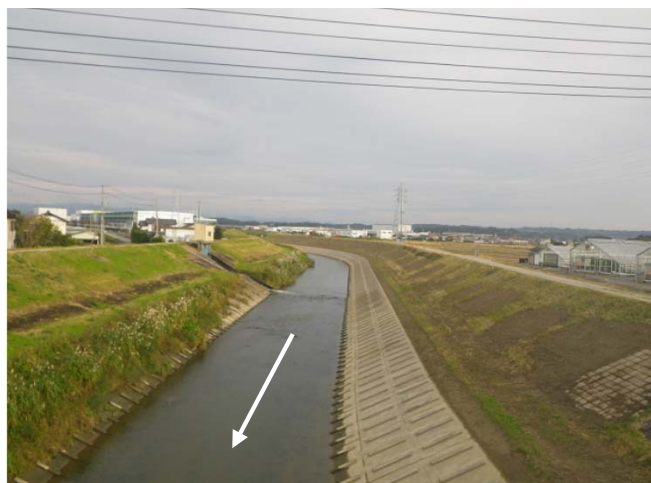
牛淵川 3.8k付近(堂山橋上流) 左岸除草状況 (H28年12月撮影)
