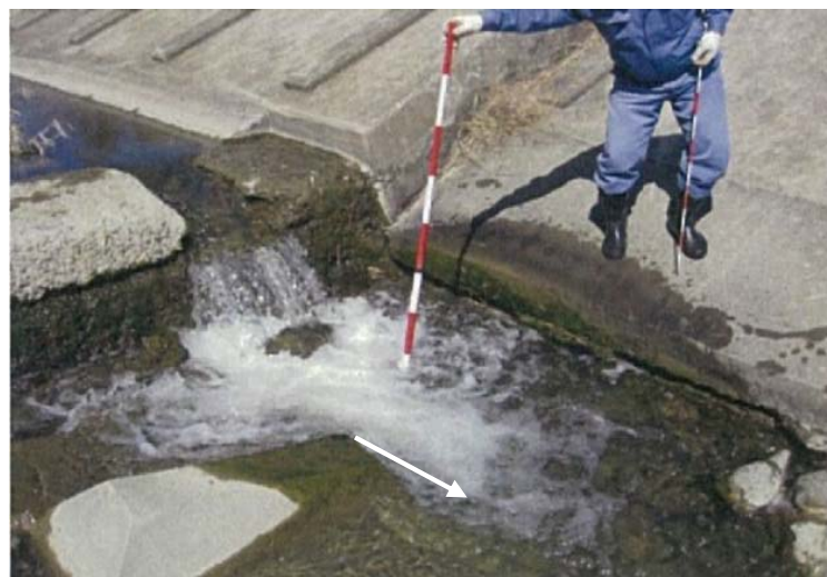
下小笠川 2.8k付近 第6床止め 基礎空洞化調査状況
