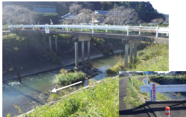
下小笠川 2.6k付近 しのがや橋(設置年 不明) (H28年11月撮影)
