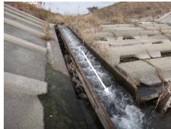
床止めに魚道を整備し、連続性を確保した床止めの例 (下小笠川 2.3k付近 第5床止め工 デニール式魚道)
