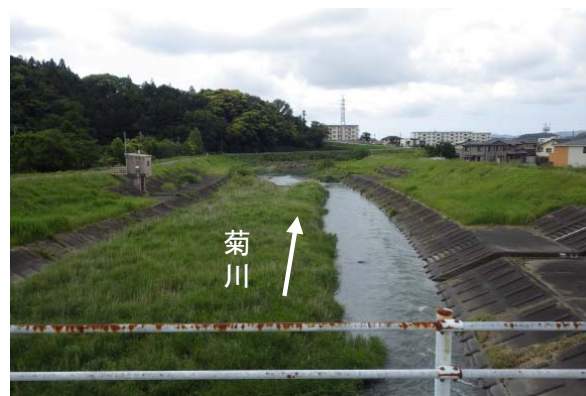
菊川 14.8k付近の河道状況(河道内土砂撤去前) (H26年5月撮影)
