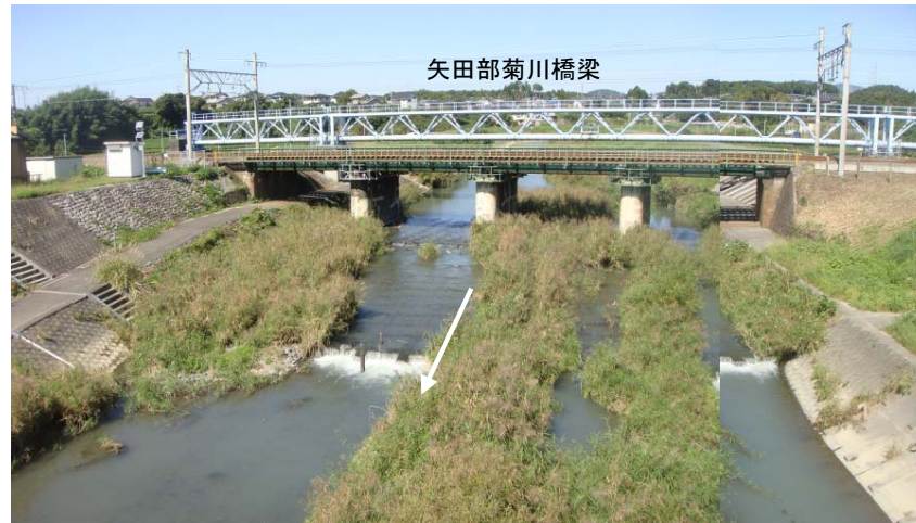
菊川 15.4k付近右岸 河道状況(H27年10月撮影)
