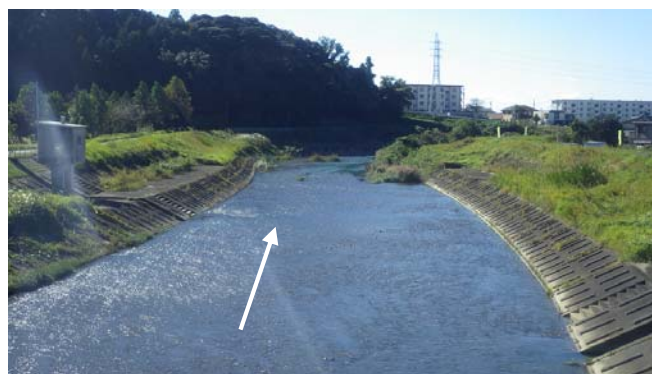
菊川 14.8k付近の河道状況(河道内土砂撤去後) (H28年11月撮影)
