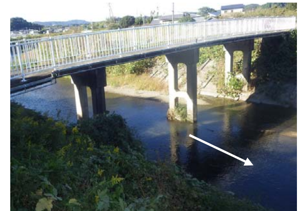
下小笠川 2.9k付近 洗心橋(昭和45年設置) (H28年11月撮影)
