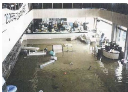
平成12 年台風14 号により浸水した西 枇杷島町役場ロビー
