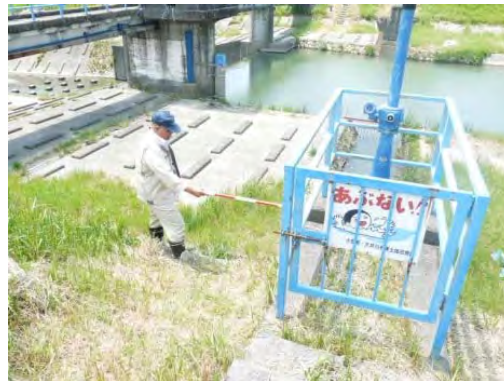
平常時における安全点検
