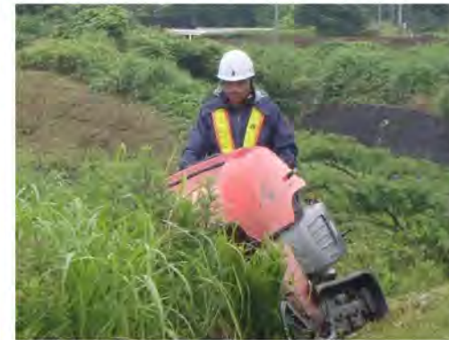
除草作業状況
