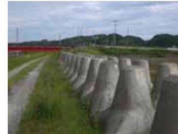
牛淵川左岸2.1k付近に備蓄されている根固めブロック
