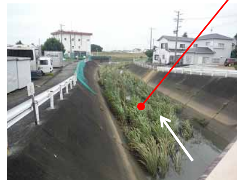
①黒沢川0.45k黒沢橋より下流を望む (改修前)
