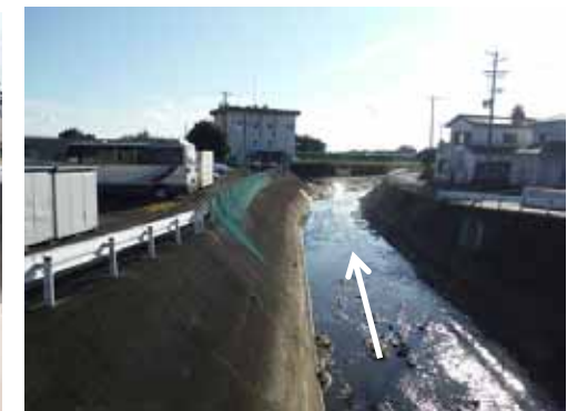
②黒沢川0.45k黒沢橋より下流を望む (改修後)
