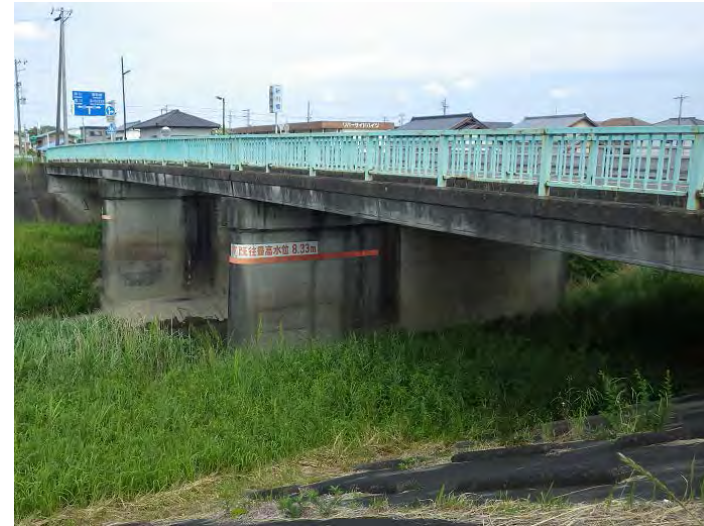
牛淵川 6k2付近 新川橋
