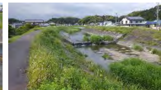
下小笠川4.0km付近の第9床止工
