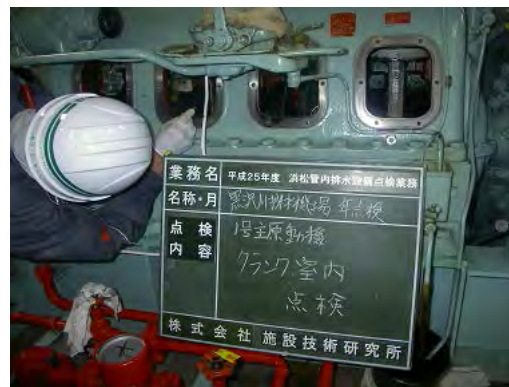
黒沢川排水機場 主原動機点検状況
