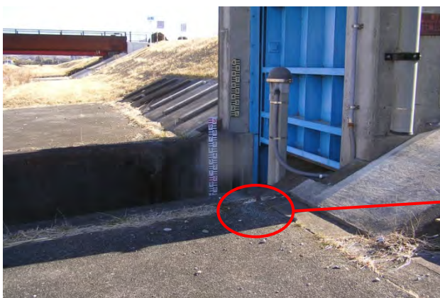
H26. 1調査 牛淵川9k8左岸 東横地樋管
