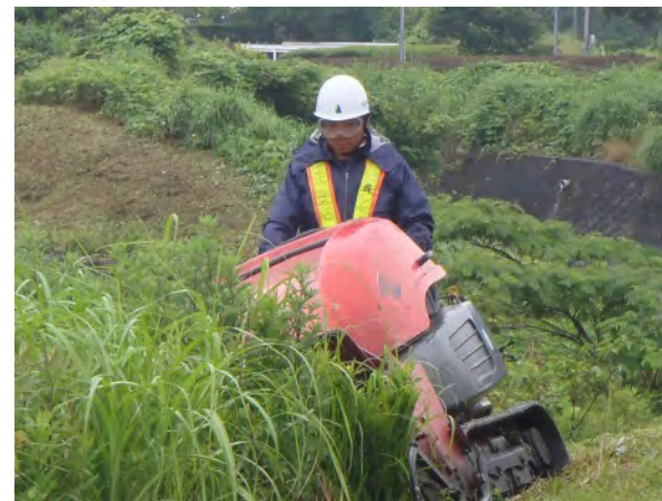
除草作業状況
