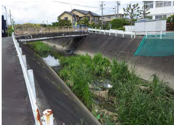
黒沢川 0k5付近 黒沢橋
