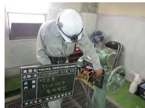
黒沢川排水機場 吐出弁点検状況
