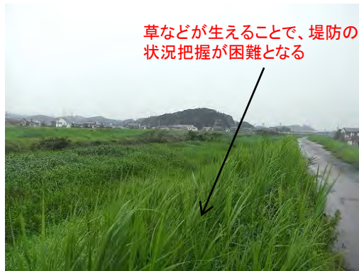
菊川 5k8付近右岸 堤防上に草などが繁茂している状況
