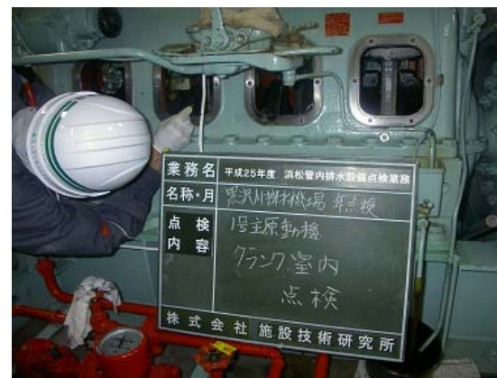
黒沢川排水機場 主原動機点検状況
