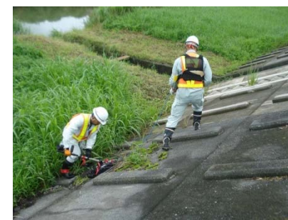
H25.6調査 牛淵川0k8右岸付近
