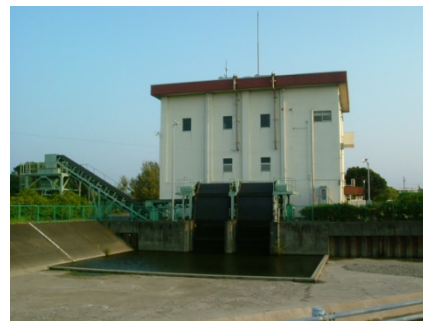
黒沢川排水機場
