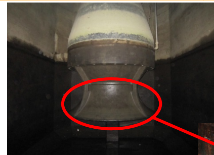
黒沢川排水樋門 監視カメラ 塗装剥離状況
