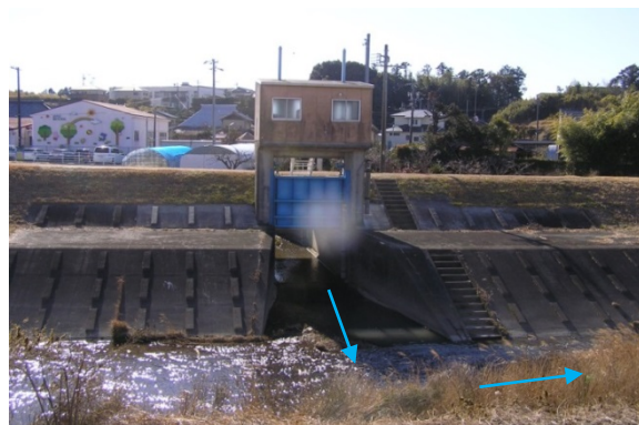
牛淵川 9k8左岸 東横地樋管(昭和51年建設)
