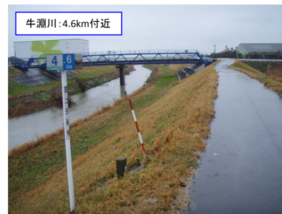
一般道路と交差する堤防
