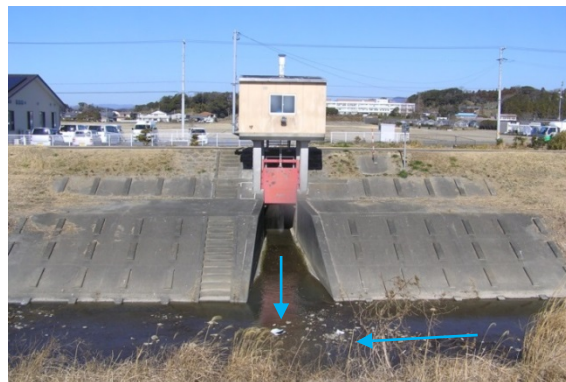
牛淵川 10k0右岸 段横地樋管(昭和51年建設)
