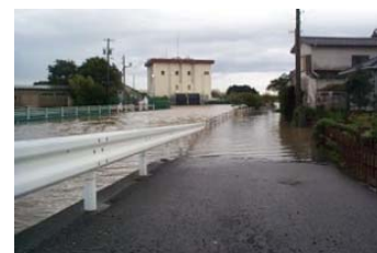
黒沢川0.4k付近右岸の浸水状況
