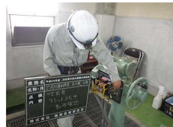
黒沢川排水機場 吐出弁点検状況
