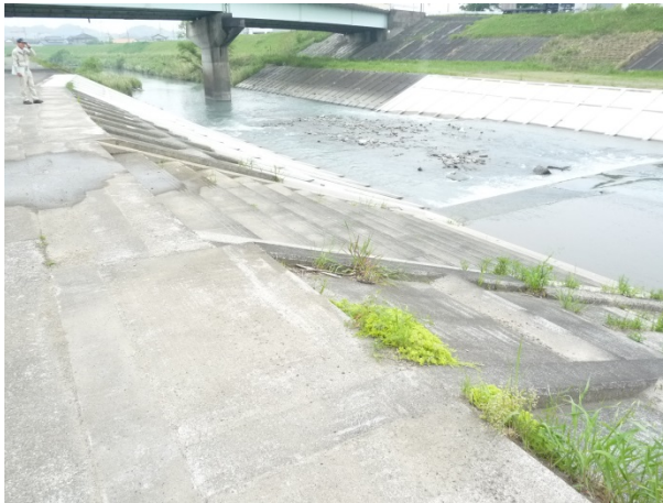
安全点検要領に基づく巡視状況
