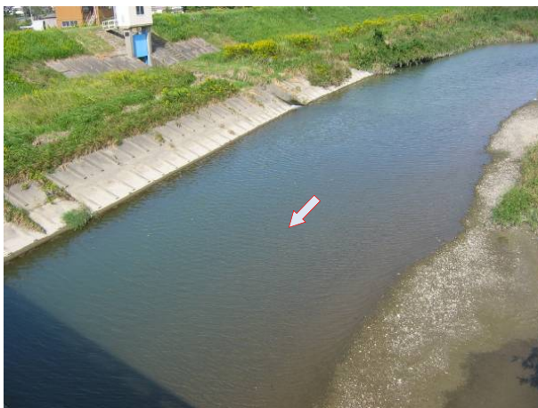
床止工等の上流側は流れが緩やかとなっている 菊川 9.1k付近
