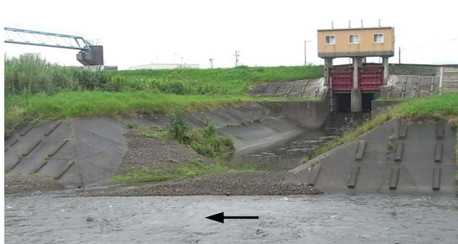
菊川5.5k右岸の七曲樋門
