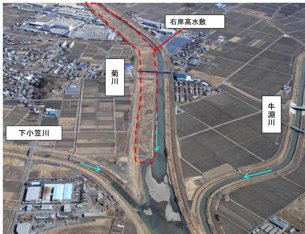
菊川 3k4上流 右岸高水敷状況
