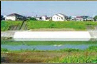
H20.6復旧工事完了
