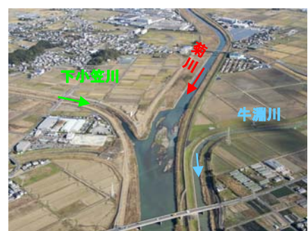
捷水路工事後の菊川・牛淵川合流点付近
