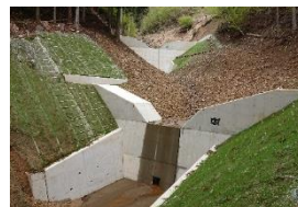
治山ダムの整備(愛知県)
