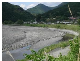
河道掘削(静岡県)
