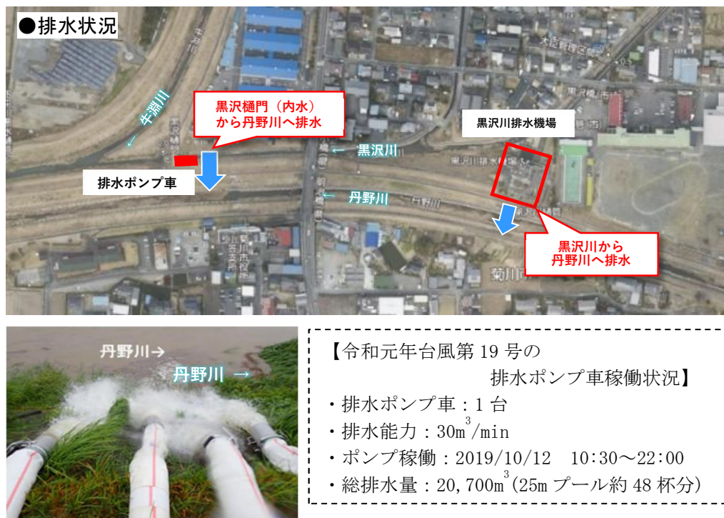
図 14 令和元年出水時の排水状況
