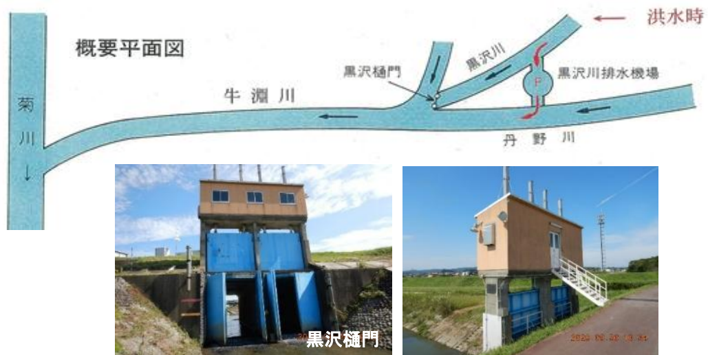
図 11 黒沢川に隣接する河川と樋門の状況
