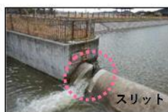
▲スリットの設置状況
