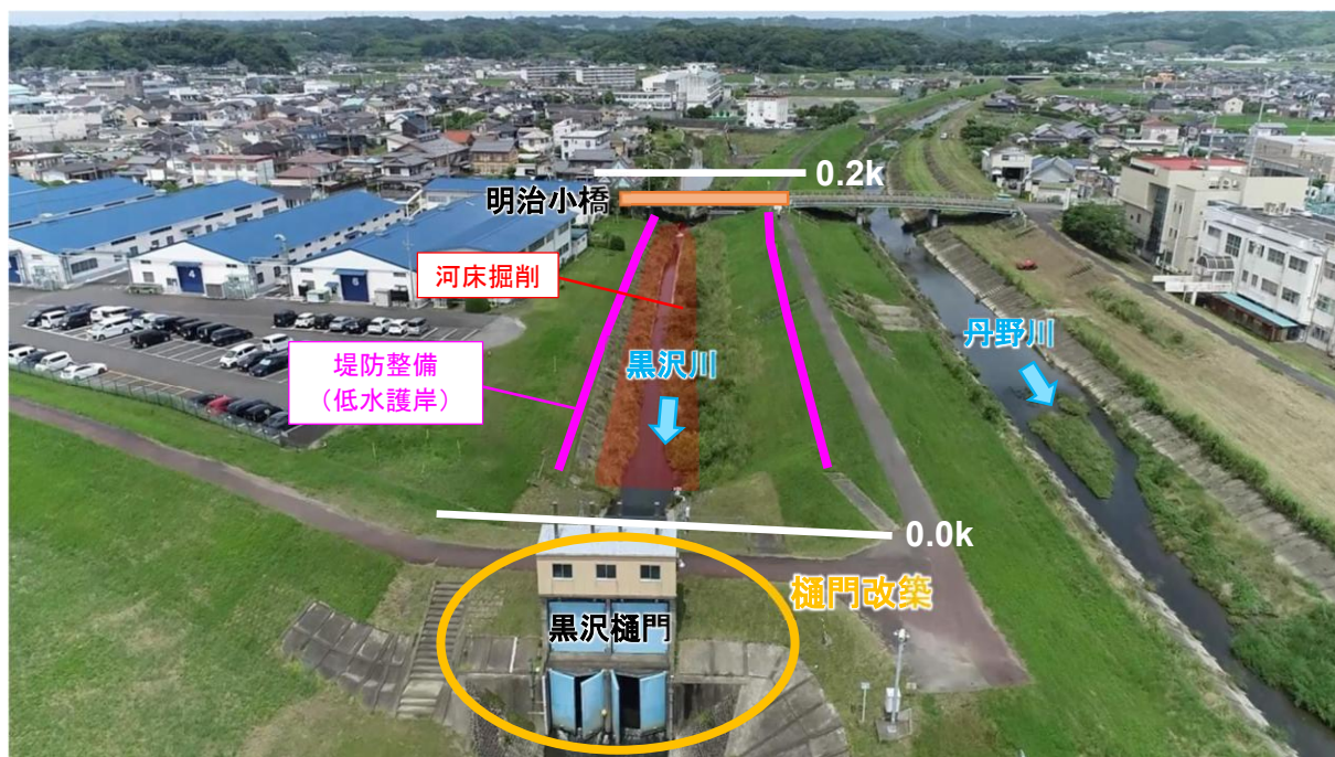
図 24 黒沢川での河川整備計画に基づく河川整備
