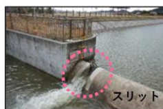
▲スリットの設置状況
