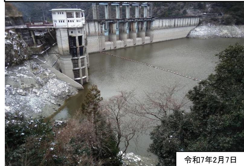
佐久間ダムの状況(ダム水位 約17m)
