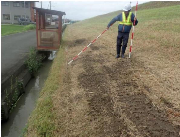
堤防の変状の点検
