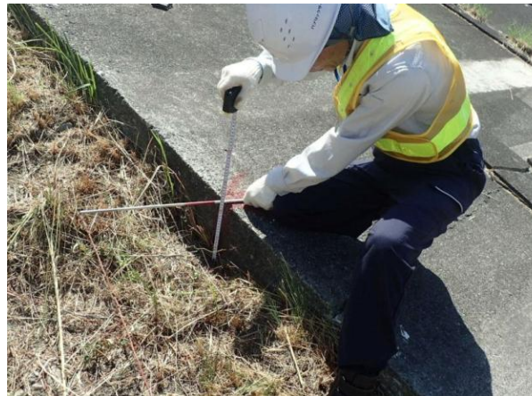
護岸の変状の点検
