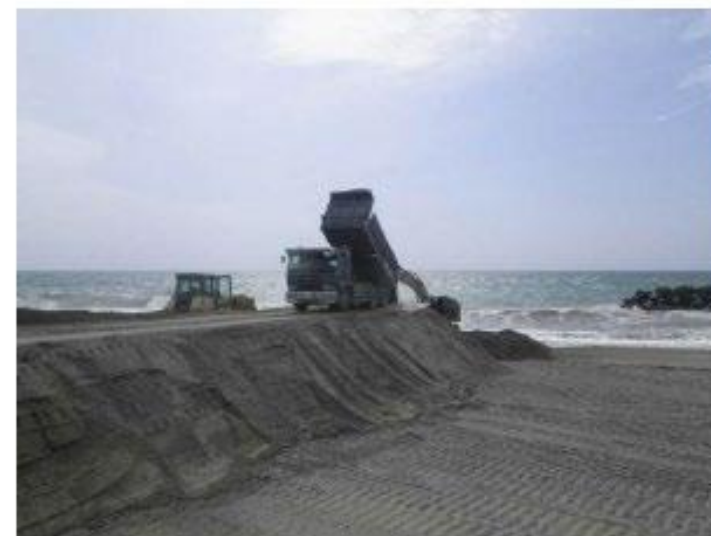
運搬及び養浜の実施（静岡県）
