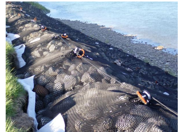
異常箇所への対応(袋詰め玉石設置)
