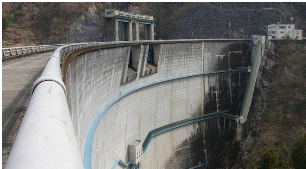
新豊根ダム 堤体
