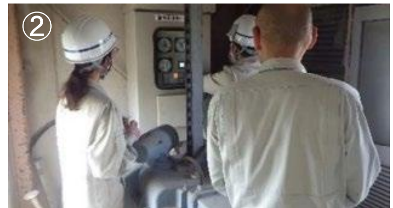
令和7年度 樋門樋管操作説明会の様子(磐田市)
