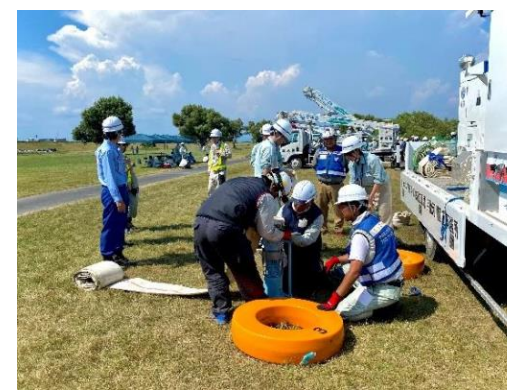
排水ポンプのホース設置準備状況 (令和5年度)
