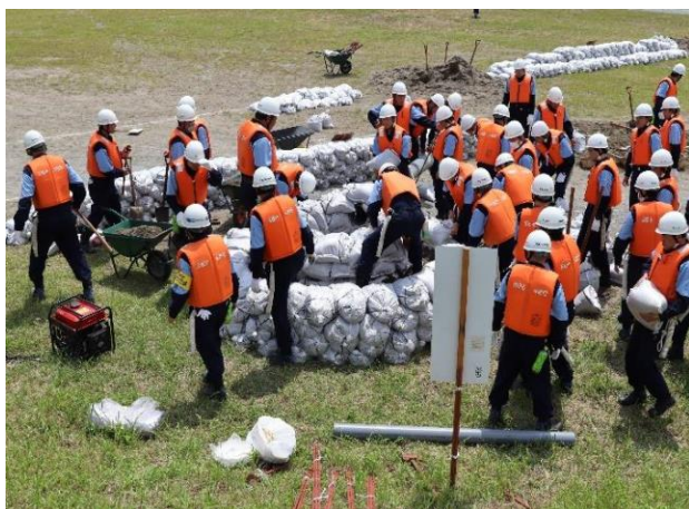
釜築工 作業状況
