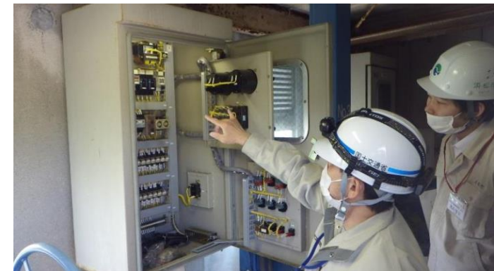
樋門樋管操作説明会の様子(浜松市)
