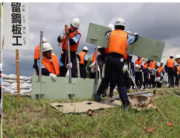
土留鋼板工 作業状況
