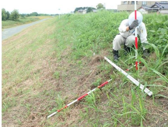
堤防の変状の点検
