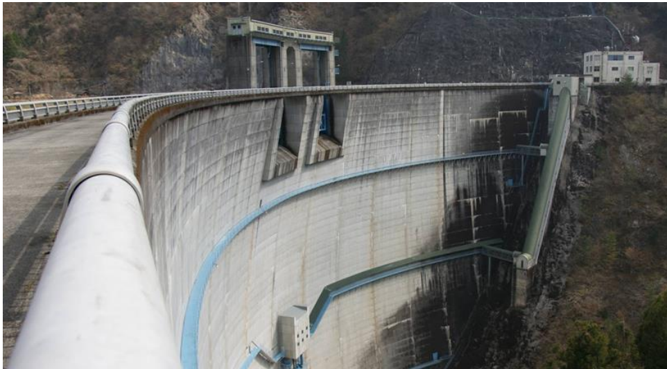
新豊根ダム 堤体
