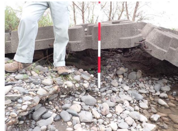
護岸の変状の点検
