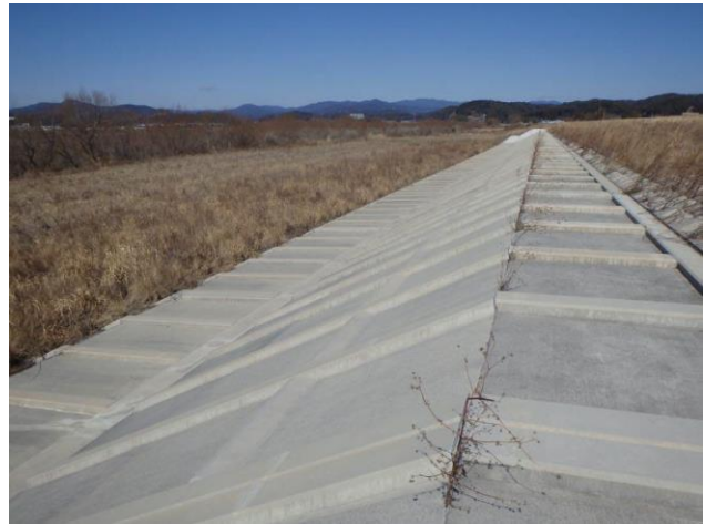
写真 6-16 左岸 22.0km 付近の低水護岸の状況
