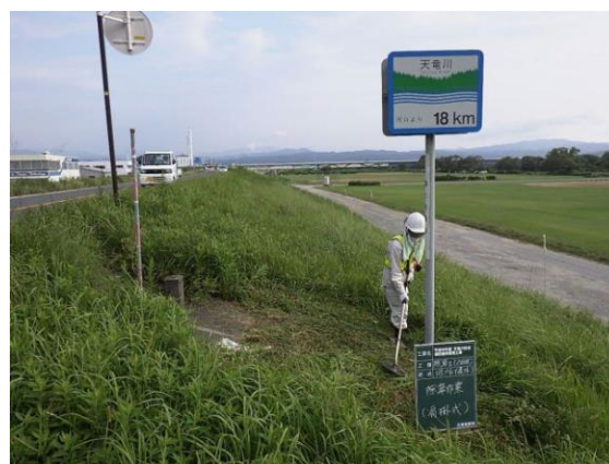
写真 6-5 肩掛式除草機械の作業状況
