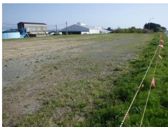
写真 6-9 左岸 6.0km 付近 第2種側帯の状況
