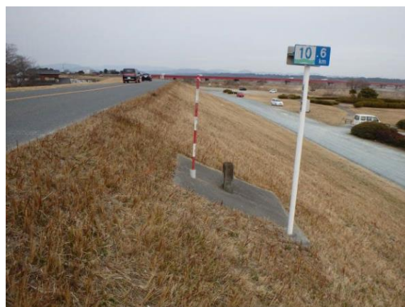
写真 6-6 右岸 10.6km の天端占用道路の状況
