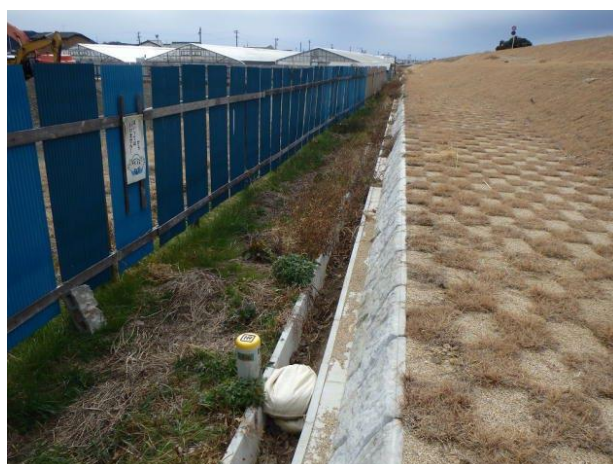
写真 6-7 左岸 16.0km 付近 堤脚保護工と堤脚水路の状況
