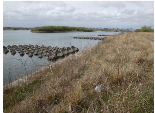
写真 6-18 左岸 2.0km 付近 水制工の状況
