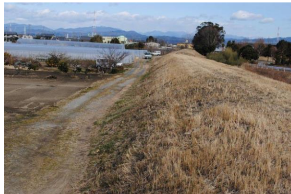
写真 6-15 二線堤：豊西堤の状況
