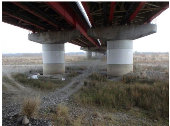
写真 6-21 右岸 11.0km 付近 東名高速道路橋脚の状況
