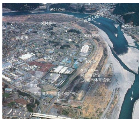
写真 6-14 二線堤：空から見た 中瀬堤の状況
