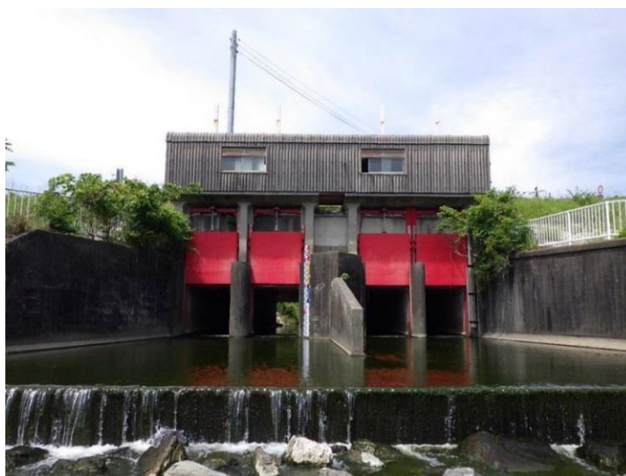
写真 6-19 右岸 16.2km 付近 八幡樋管の状況
