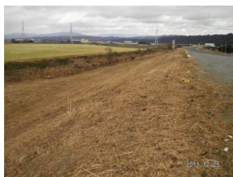
写真 6-13 地上から見た岩田堤の状況
