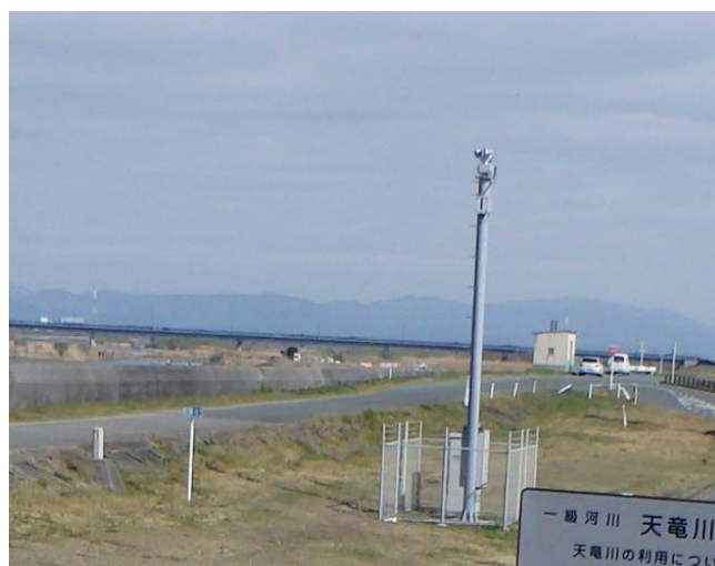
写真 6-20 左岸河口部 河川管理用カメラの状況
