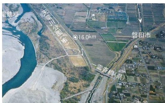
写真 6-12 霞堤：空から見た岩田堤 (下流から上流側を臨む)
