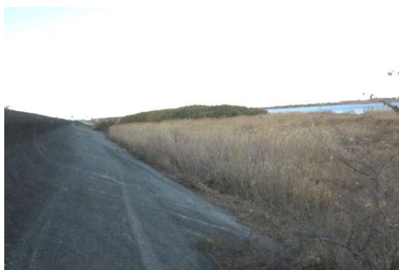
写真 6-10 右岸 0.6km+10 付近高潮堤の状況
