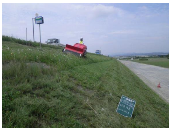
写真 6-4 ハンドガイド式除草機械の作業状況
