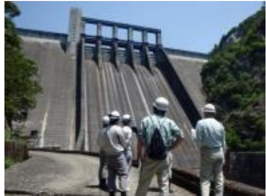
写真 5-2 佐久間ダム下流の点検状況
