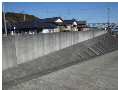
写真 6-11 左岸 25.0km 特殊堤の状況
