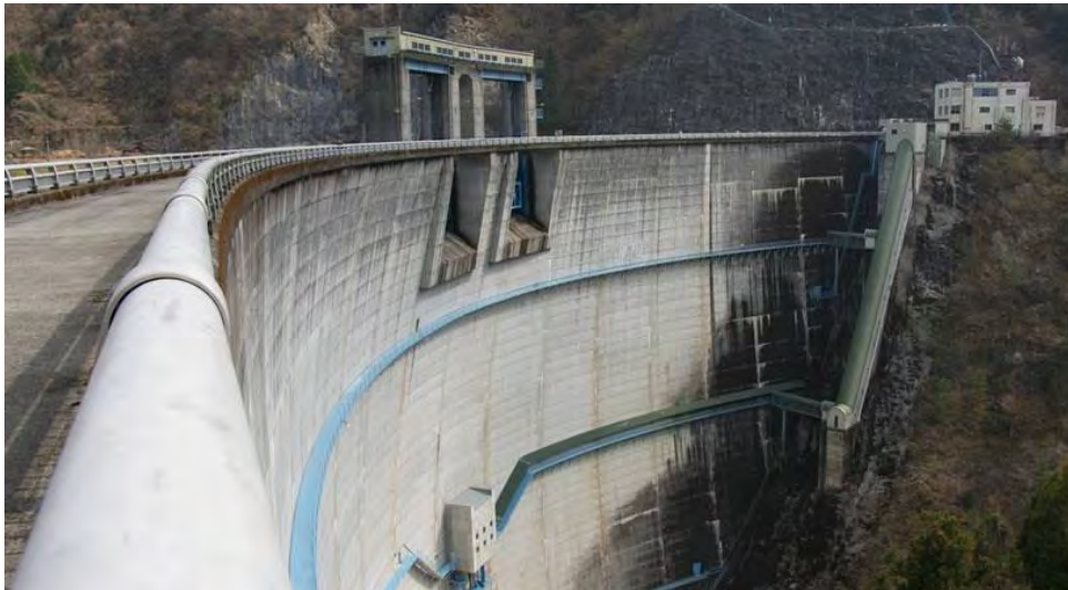
新豊根ダム 堤体
