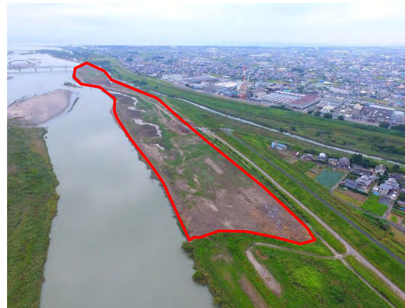
4.5k付近 施工完了(令和4年12月撮影)
