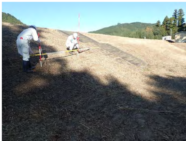
堤防の変状の点検
