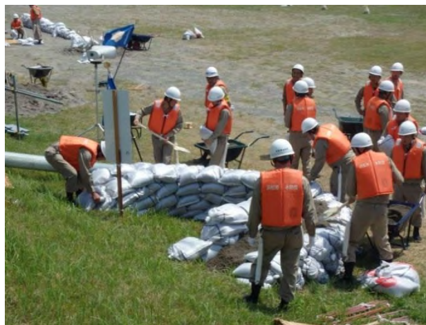
月輪工 作業状況
