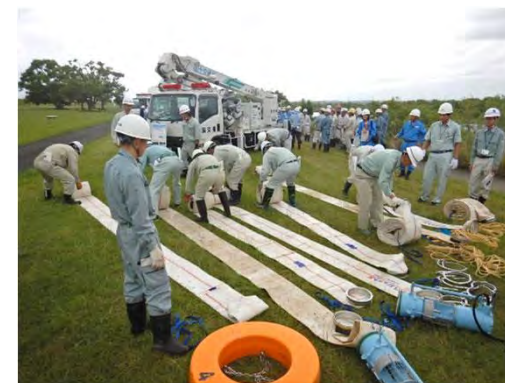
排水ポンプのホース設置準備状況
