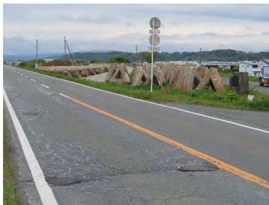
左岸 11.8k付近に備蓄されている 根固めブロック等
