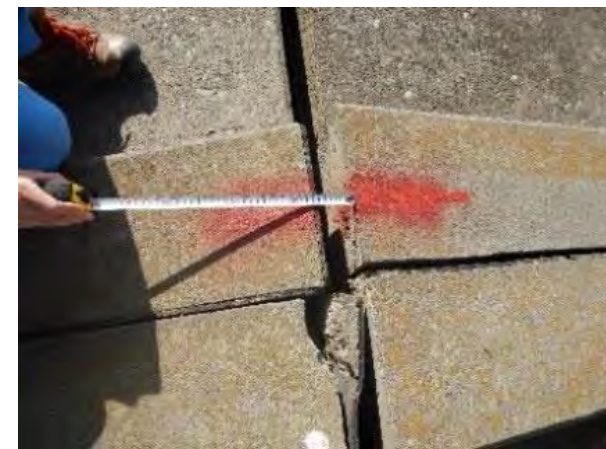
護岸の変状の点検
