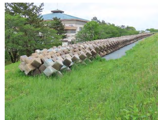
左岸 19.6k付近に備蓄されている 根固めブロック等
