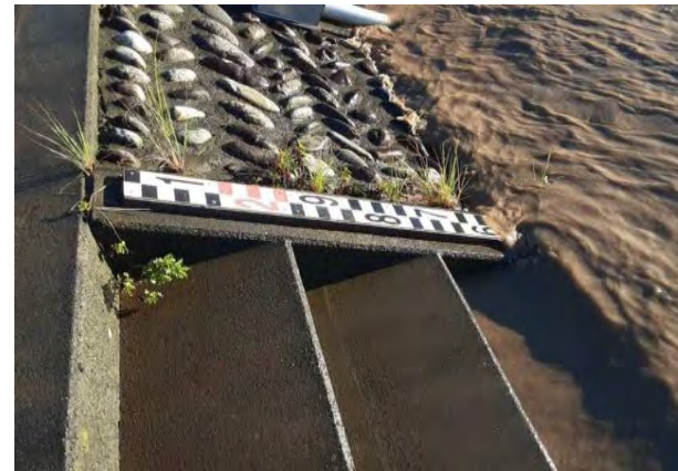
台風15号に伴う出水時巡視写真(右岸)
