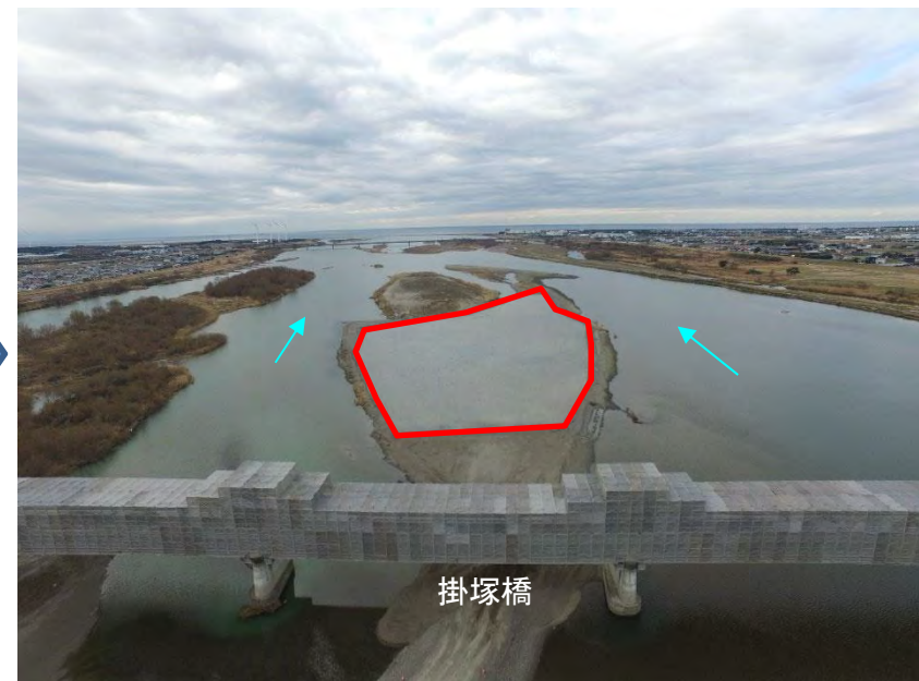
3.0k付近 施工完了(令和5年2月撮影)
