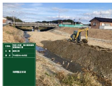
河道堆積土砂の掘削
