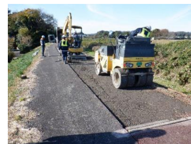
堤防天端道路の補修
