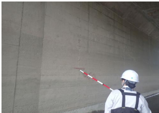
樋管点検の様子
