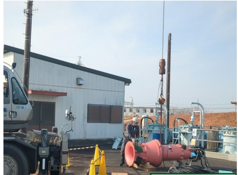
排水ポンプ設置状況
