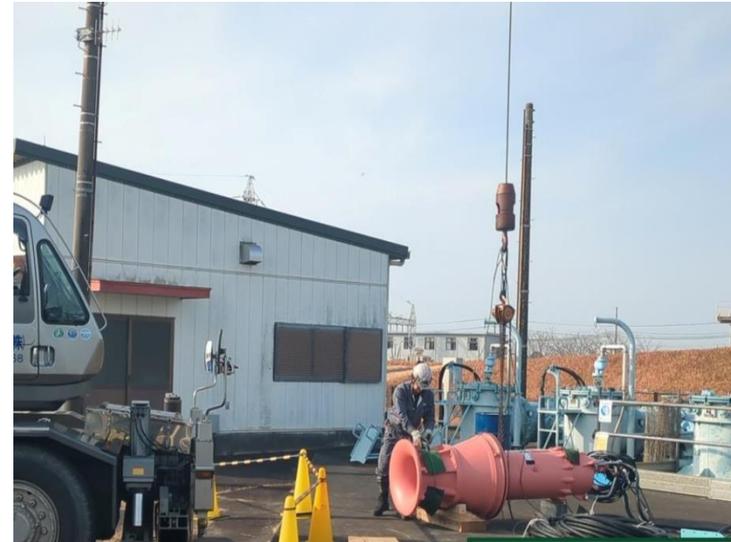
排水ポンプ設置状況
