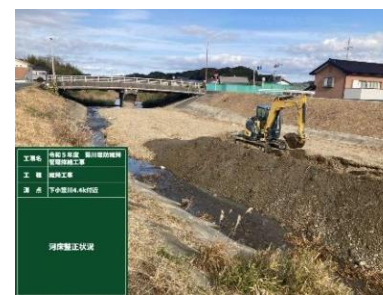
河道堆積土砂の掘削
