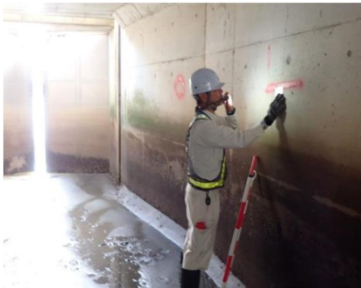
樋管点検の様子
