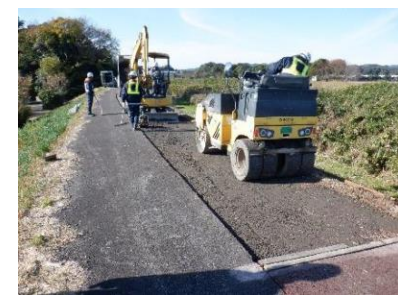
堤防天端道路の補修
