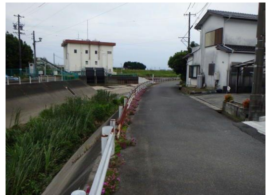
写真 2-9 黒沢川排水機場付近
