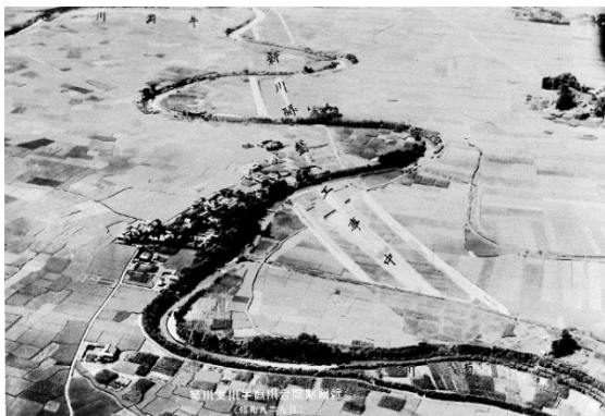
写真 2-3 昭和 8 年 9 月の菊川 4.0km （花面橋付近）（捷水路着手前）
