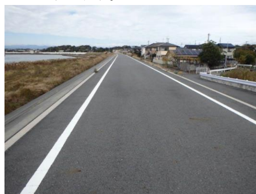
写真 6-11 菊川左岸 1.2km の高潮堤
