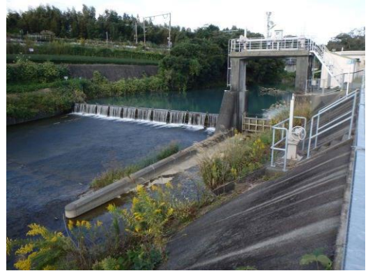
写真 2-8 菊川頭首工堰(17.6km 付近)
