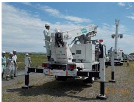
写真 6-20 照明車の操作訓練状況
