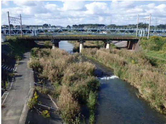
写真 2-12 鉄道橋（JR 東海道本線橋）
