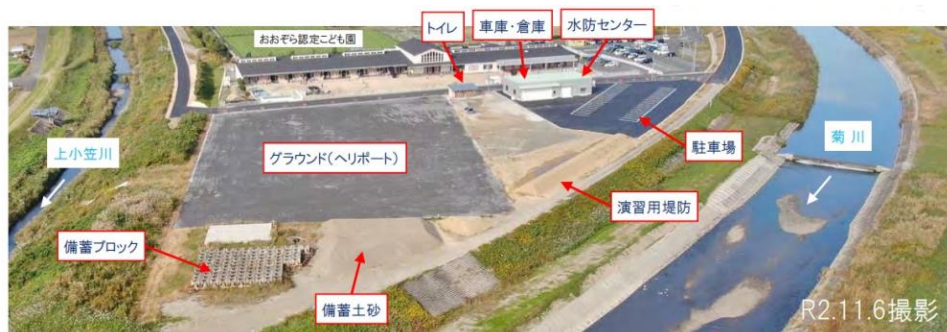
写真 2-10 菊川下内田地区河川防災ステーション
