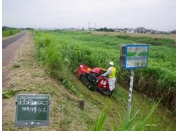
写真 6-5 ハンドガイド式除草機械の作業状況
