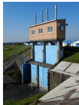
写真 2-5 牛淵川 黒沢樋門
