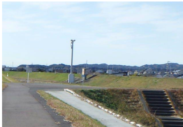
写真 5-5 河川管理用カメラ（CCTV）の 設置状況（黒沢川合流点）
