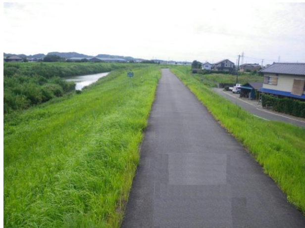
写真 2-2 堤防天端の状況
