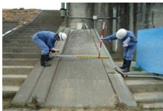
写真 6-12 樋管取付護岸の点検状況
