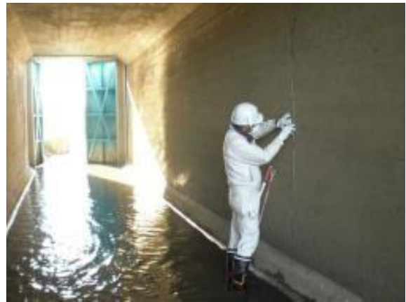
写真 5-3 樋管の点検状況
