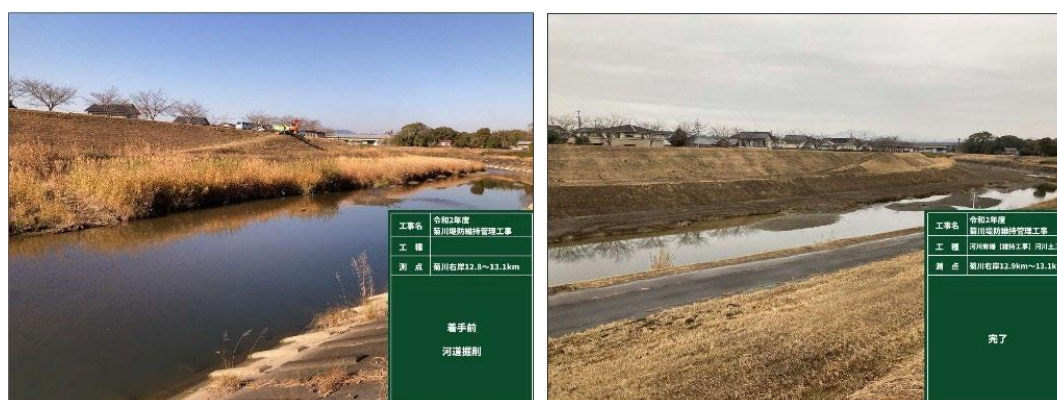
写真 6-1 菊川右岸 13.0km 付近の河道内堆積土砂の状況 (左：河道掘削前、右：河道掘削後（令和2年度時点）)
