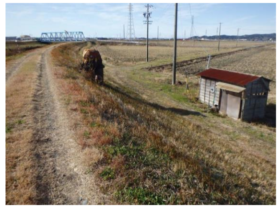
写真 2-13 牛淵川 揚水機場
