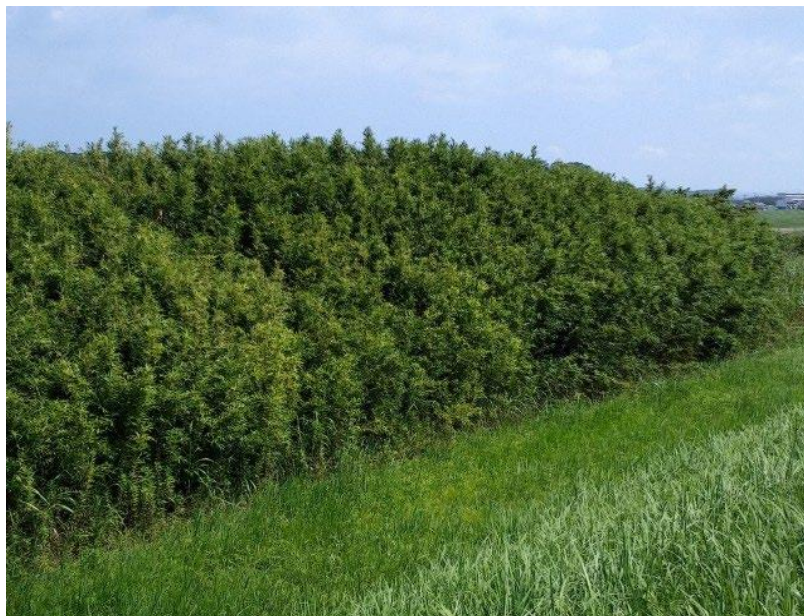
写真 2-1 菊川における樹木繁茂状況 (左岸 3.4km 下流付近、メダケ群落令和 5 年度時点)
