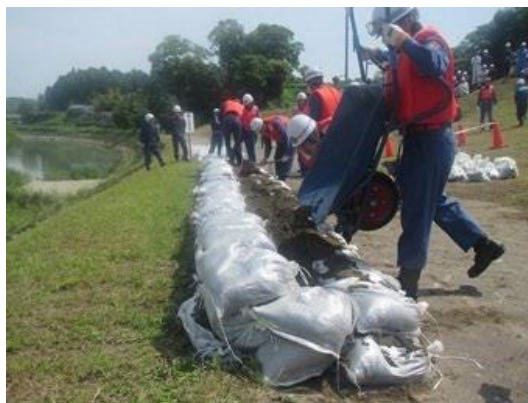
写真 2-14 水防訓練の状況
