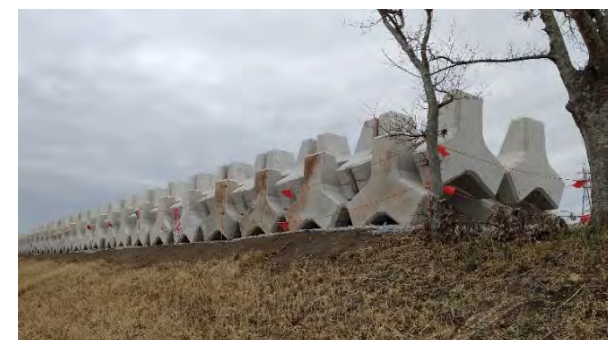
菊川 左岸8.7k付近に備蓄された備蓄ブロック
