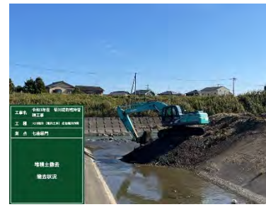
樋管堤外水路の土砂掘削
