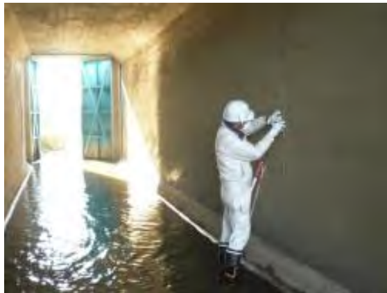
樋管点検の様子
