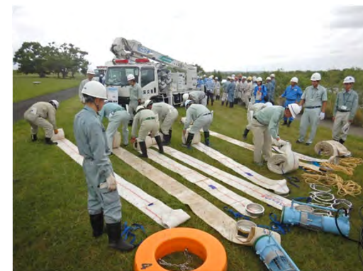
排水ポンプのホース設置準備状況
