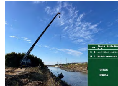
維持工事(護岸補修)
