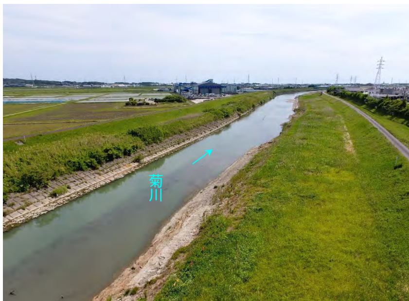
菊川右岸5.1k付近 着手前
