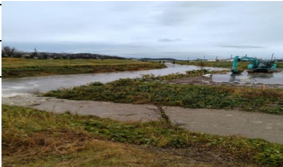
①下前田川増水時の工事現場 11月17日
