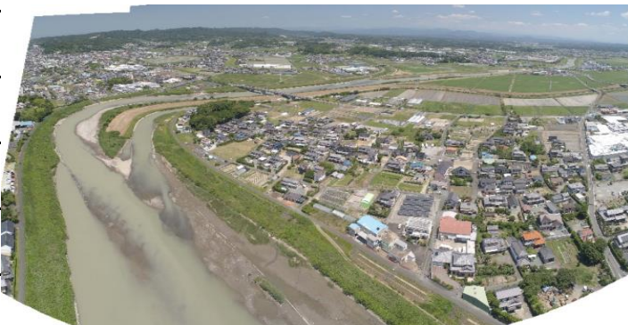
【国安橋ー鹿島橋（パノラマ）】
