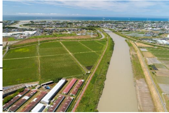
【花面橋ー鹿島橋】
