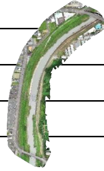
10. 加茂橋－新菊川橋
