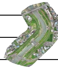
5. 八王子橋—矢田部橋
