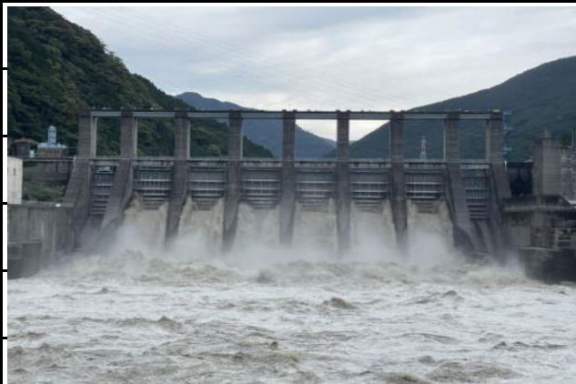
排砂ゲートを除く全門放流中
