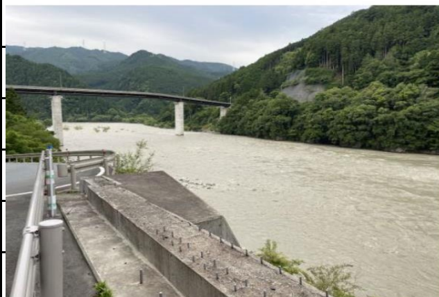
天竜68.5左旧原田橋付近
