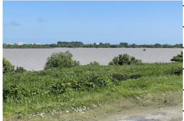
下流の様子 (新貝CCTV付近)
