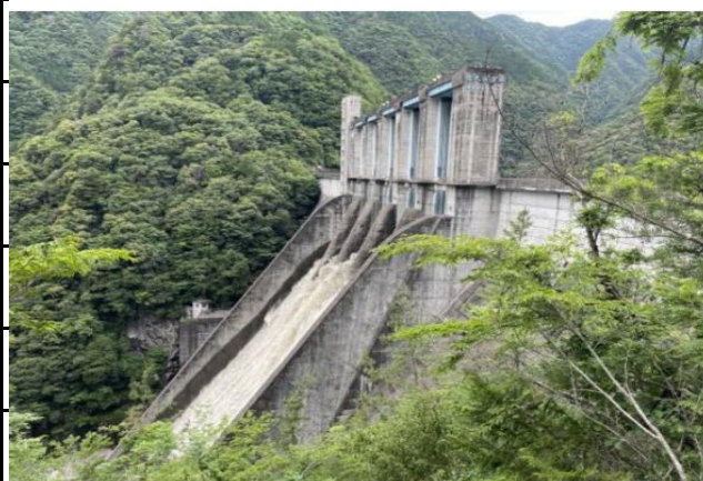
佐久間ダム放流左岸から
