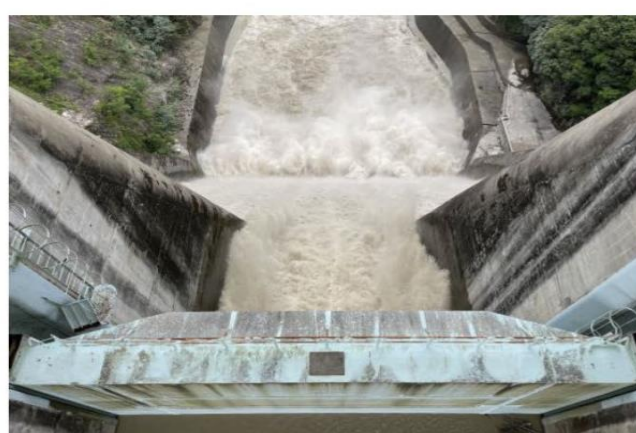
佐久間ダムゲート天端から
