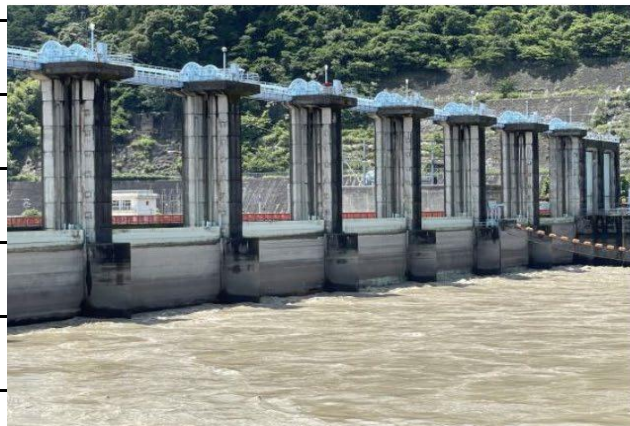
上流の地区を浸水から守る為調整池の水位を低下しています
