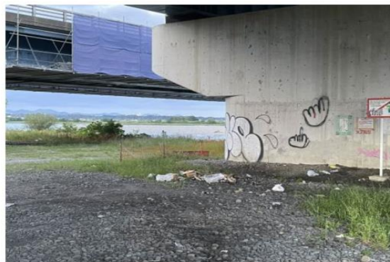
天竜川9.5kp 天竜川橋桁付近
