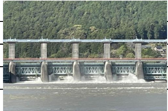
船明ダムローラーゲートの様子
