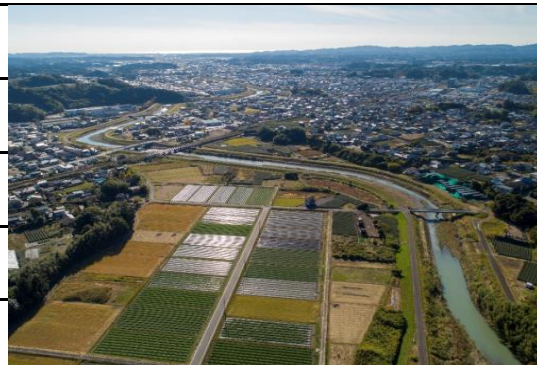
【潮海寺橋－水神橋】
