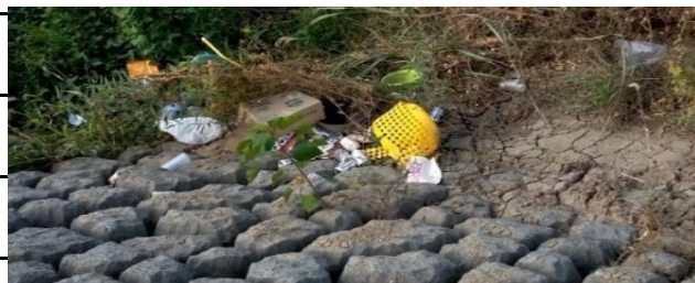
第一橋脚 南西4m
