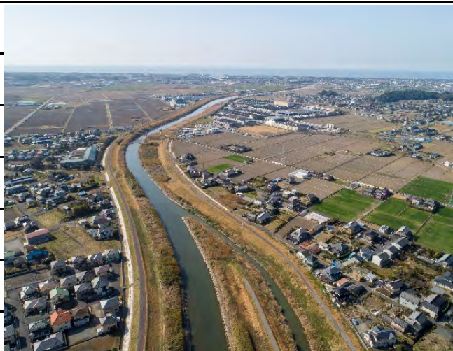
【生仁場橋～七曲樋門】
