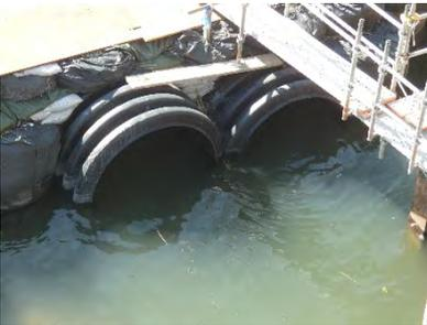
橋脚耐震補強工事のために、一時的に川の水があたらないよう「仮締切」を設置しています。
